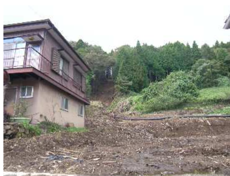
民家近くで発生した土砂災害
