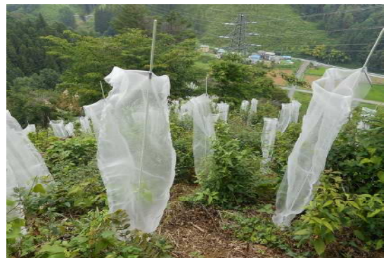
植栽木への防護ネット施工状況
