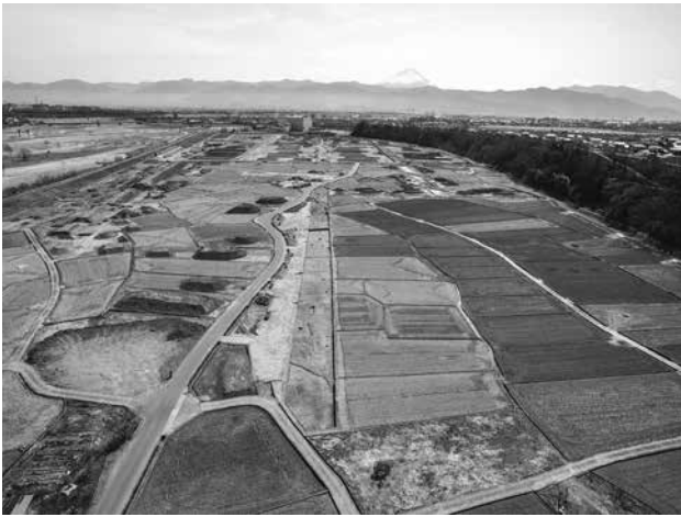
第1工区・第2工区 全景
