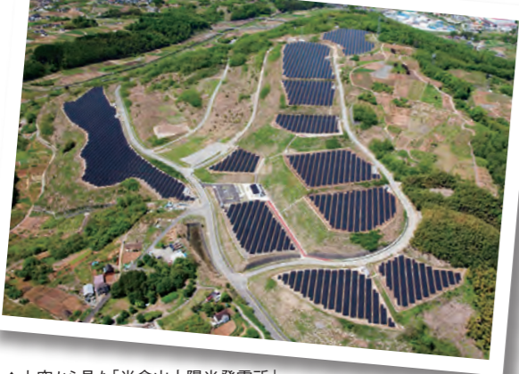
▲上空から見た「米倉山太陽光発電所」
