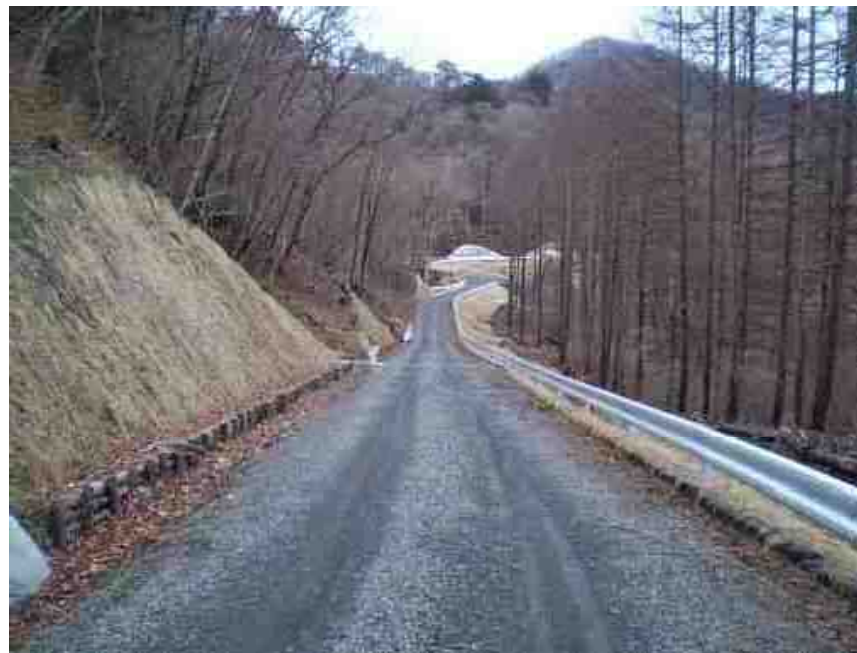
完成区間（コスト縮減により未舗装）の状況
