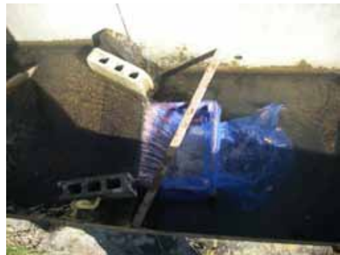
図3 ヤナ：水路の落差部分を利用して、ブロックを用いて排水をネットに導いた。
