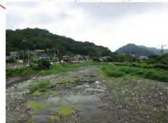
常葉川「新常葉川橋」上流
