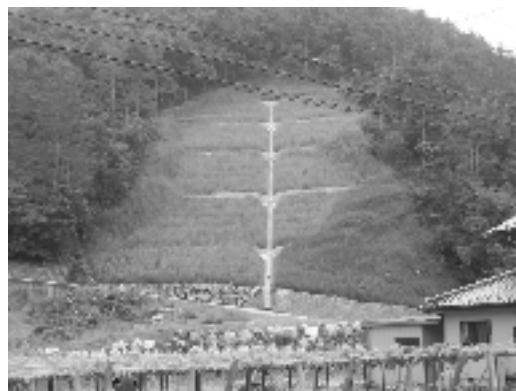
治山事業による山腹工施工地
