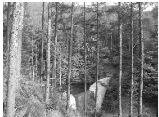
整備された森林と治山堰堤
