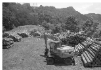
ストックヤードにおける材の集積
