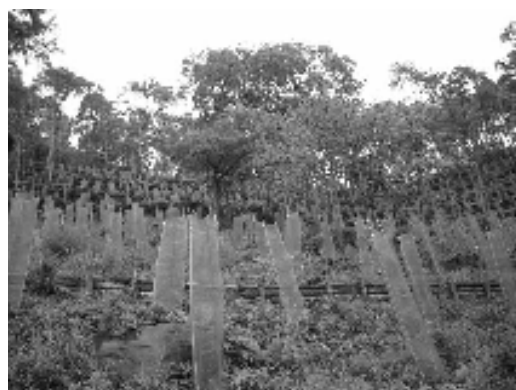
植栽木への防護ネット施工状況
