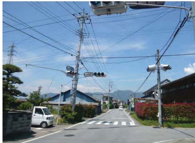
②鴨居寺入口交差点付近（幅員狭小、歩道なし）
