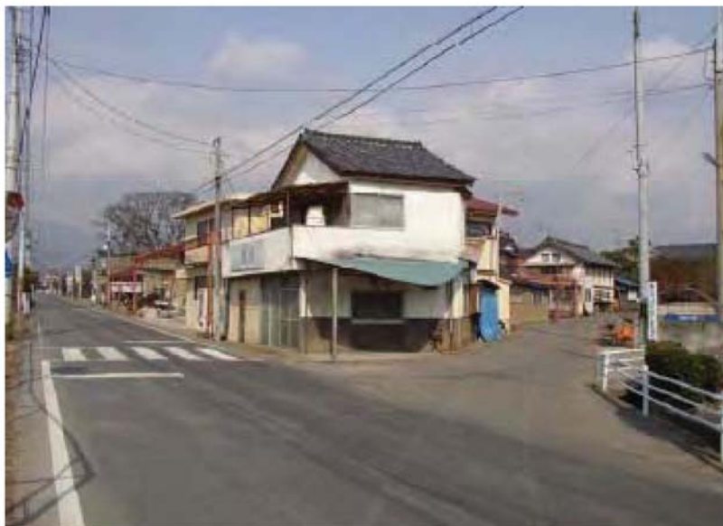
③中間地点付近（幅員狭小、歩道なし）
