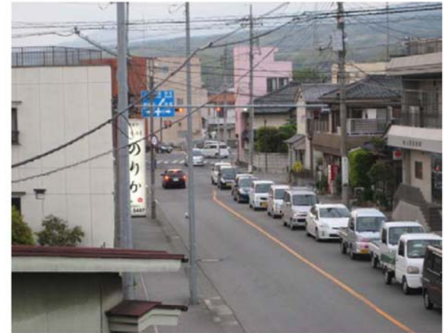
①国道20号側から下宿交差点を望む
