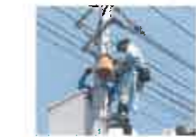
外線工事 普段体験できない高所作業車などを使用して、家庭までの電気の流れを勉強します。
