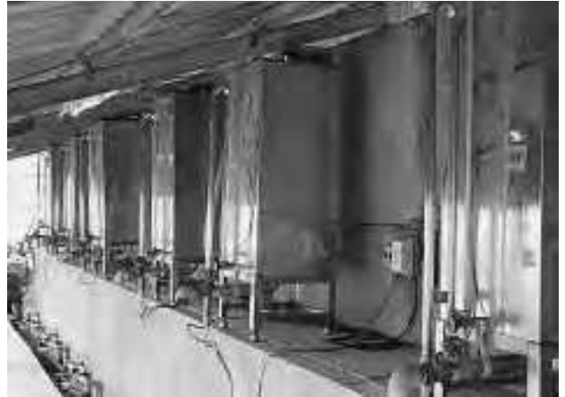
写真-11 ライシメーターの貯水槽
