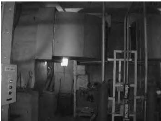
図23 煙突室 (煙突基部空間)
