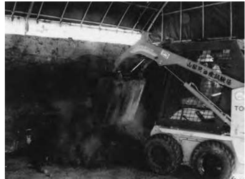
写真-6 重機による切り返し
