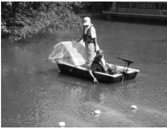
図2 植栽及び保護ネットの敷設
