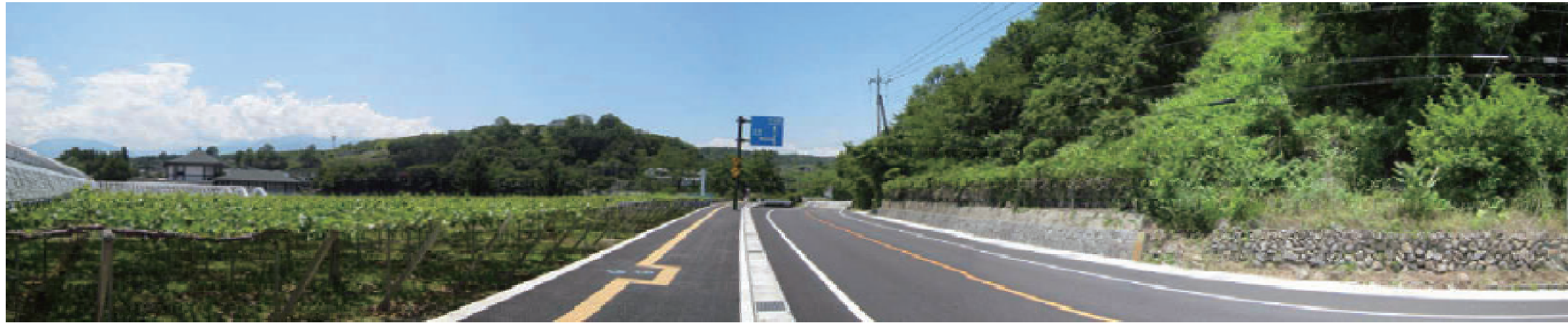
写真-86 県道 7 号(甲府市山宮昇仙峡ライン)、県道 101 号(甲斐市牛句敷島竜王線)を通過する区間 (地点 32)
