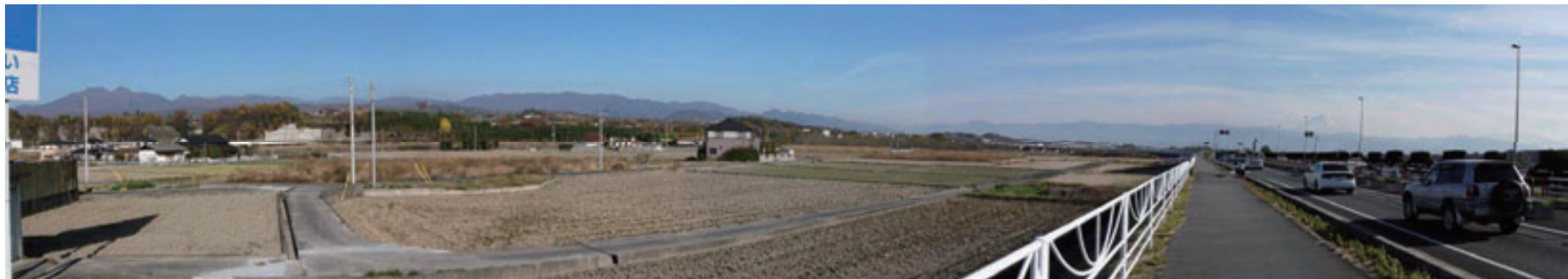
写真-59 国道 20 号線からの景観（地点 24）
