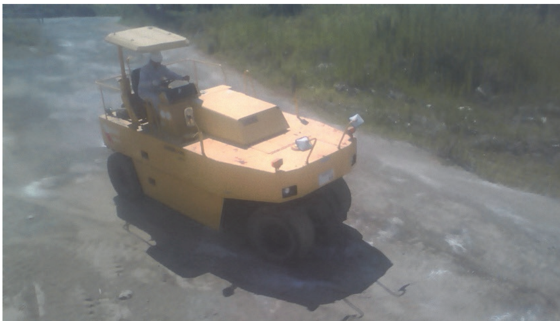
(塩化カルシウム散布後散水状況)
