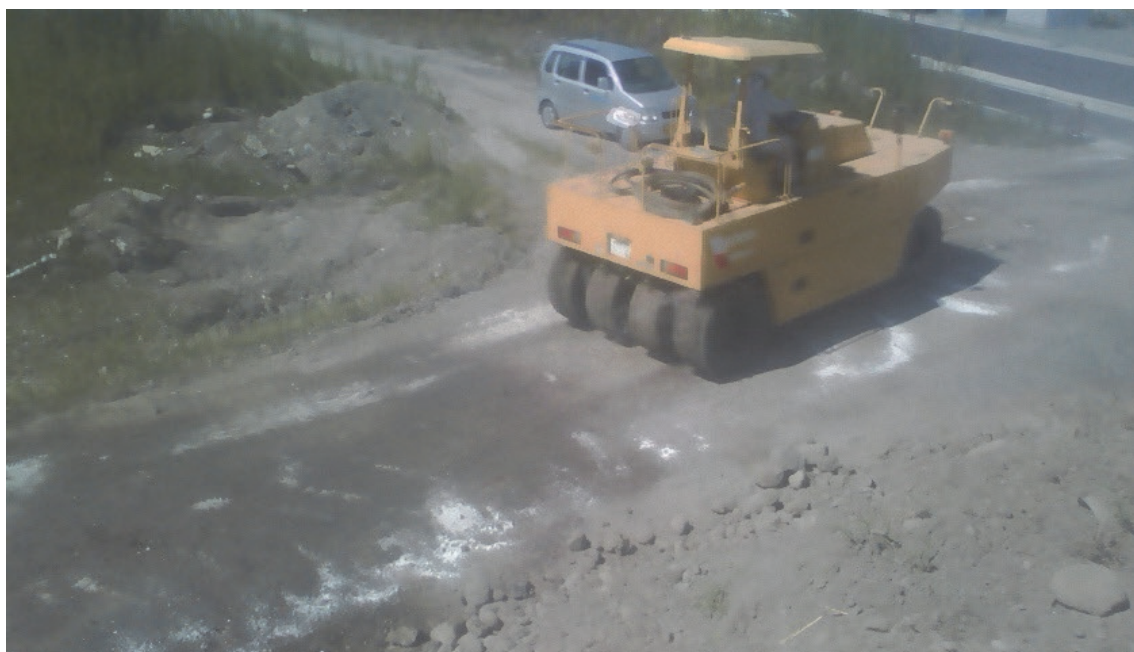
(塩化カルシウム散布後散水状況)
