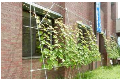
ぶどうを利用した緑のカーテン 【東山梨合同庁舎】
