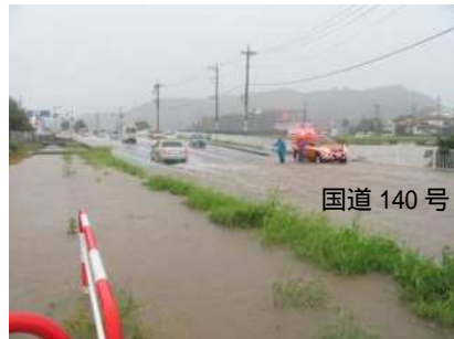
間門川流域 浸水状況
