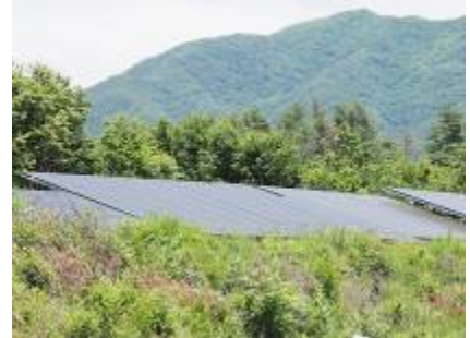
野建て太陽光発電施設
