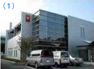
ヤマト科学株式会社南アルプス工場
