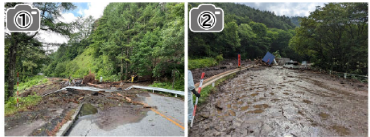
主要地方道北杜富士見線(山梨県北杜市大泉町谷戸地内)土砂流出 令和5年7月20日 土砂流出により延長約9.3kmにわたり全面通行規制を実施
