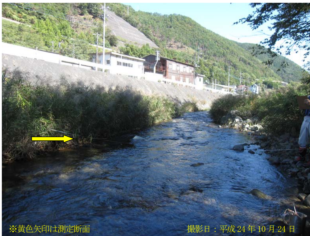
写真 10-7-1(3) A3 測定地点（上流から下流に向けて撮影）
