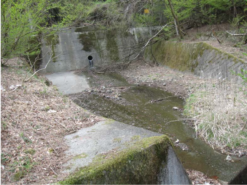
写真 1-4-1 沢水の取水地点
