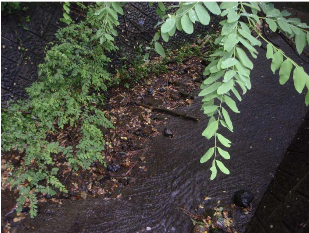
写真 1-4-2 排水放流地点
