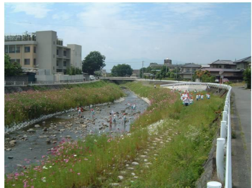
生態系※に配慮した河川整備（相川）
