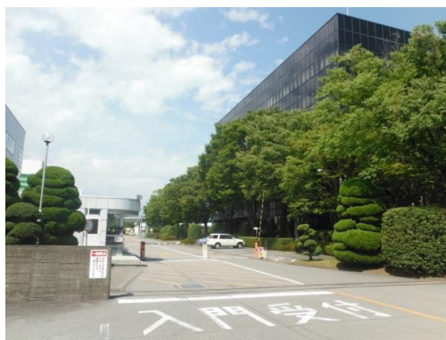
工場の緑化事例
