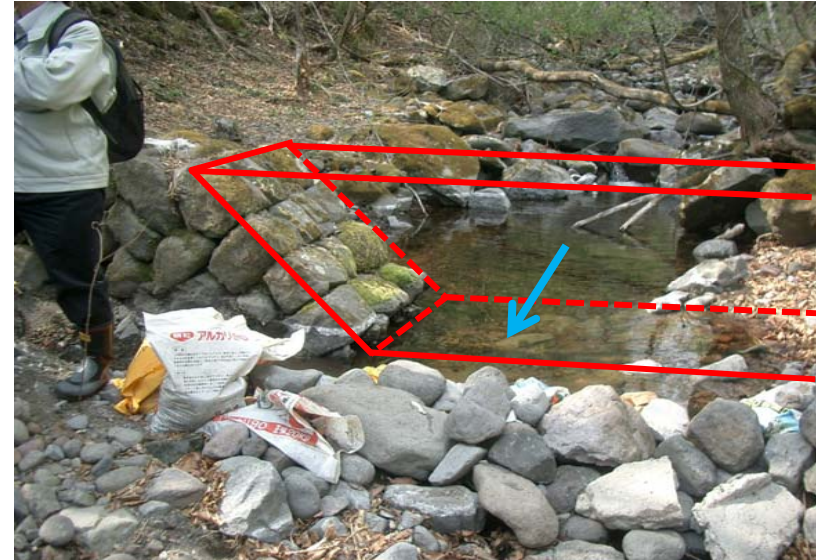
①取水堰が崩壊し、土のうを敷き詰め取水している。
