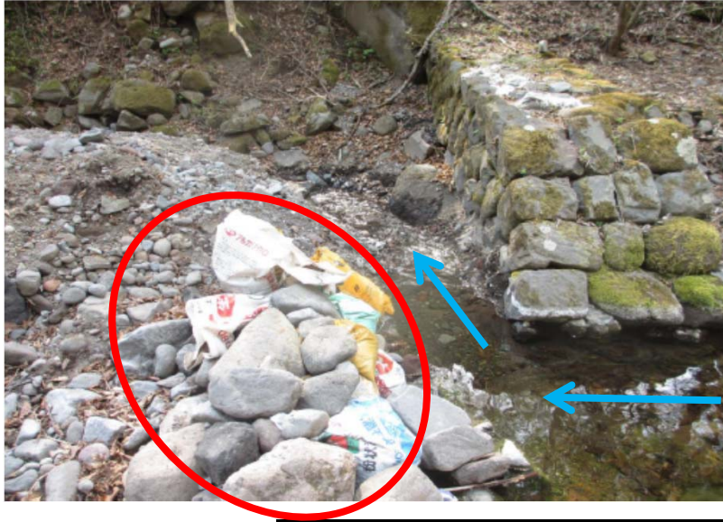
①取水堰が崩壊し、土のうを敷き詰め取水している。
