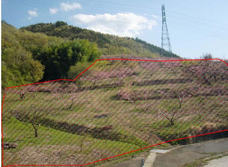
⑤現況写真 急な傾斜で区画形状も悪く、農作業効率が悪い。
