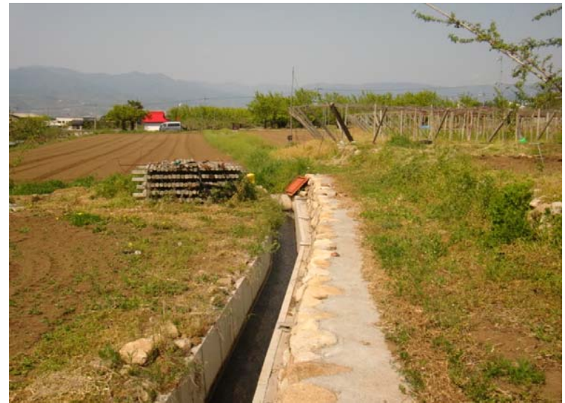
②完成後 土水路をライニングすることで漏水はなくなり、維持管理も大幅に軽減された。また土留めに在石を利用するなどコスト縮減を図った。
