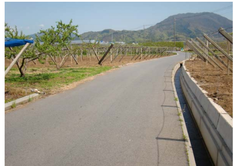
④完成後 農耕車が容易にすれ違える幅員を確保し、農作業の利便性が向上した。また舗装によって荷傷みも減少した。
