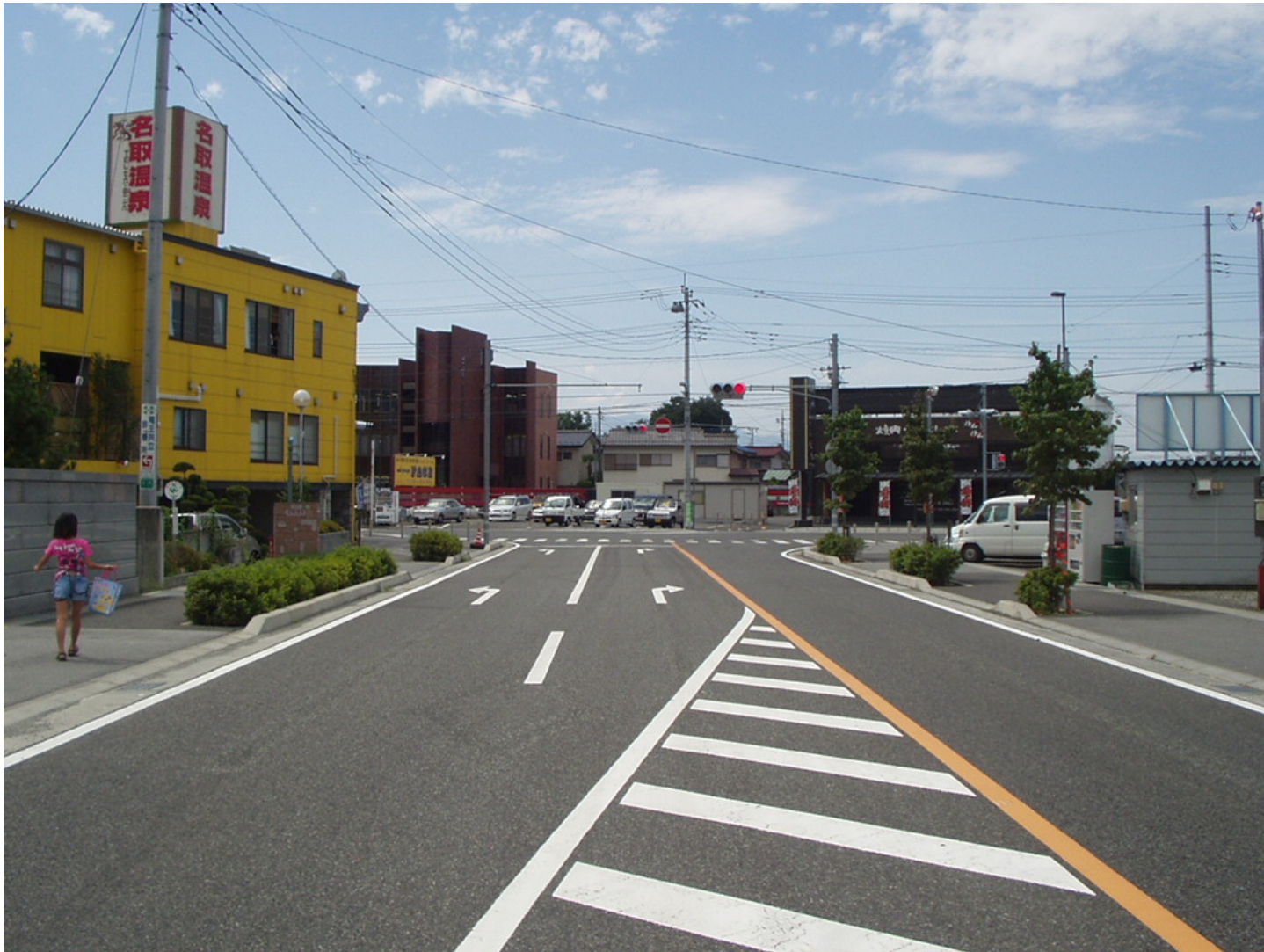
国道52号交差点部
