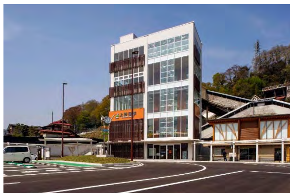
上野原駅南口昇降施設棟（ソアールプラザ）
