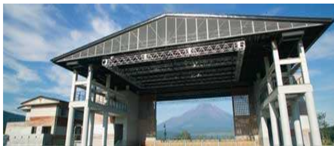
ステージ背後に、富士山への眺めを取り込んだ文化施設整備事例（シアターひびき）
