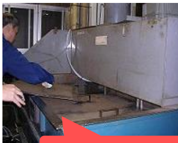
洗浄槽のフタ閉め
