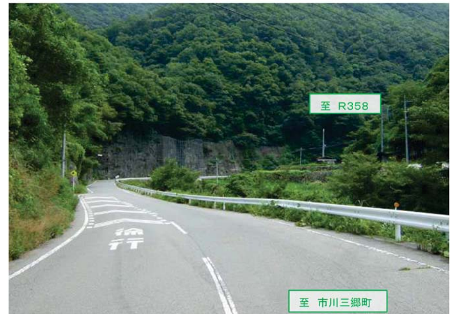
④現道 終点部
