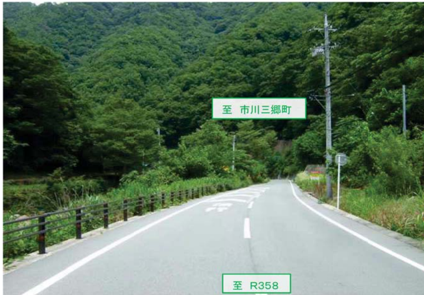
①現道 起点部
