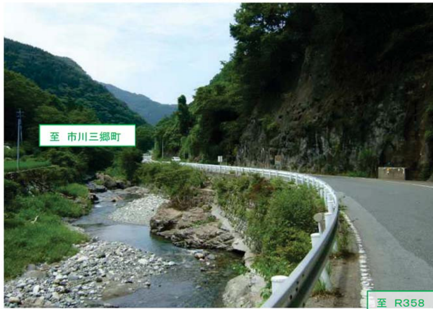
②現道 狭小幅員箇所
