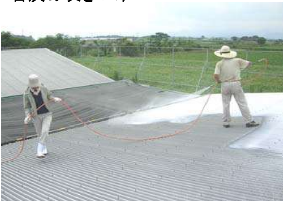
石灰の吹きつけ
