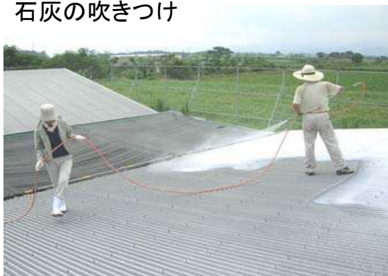
石灰の吹きつけ
