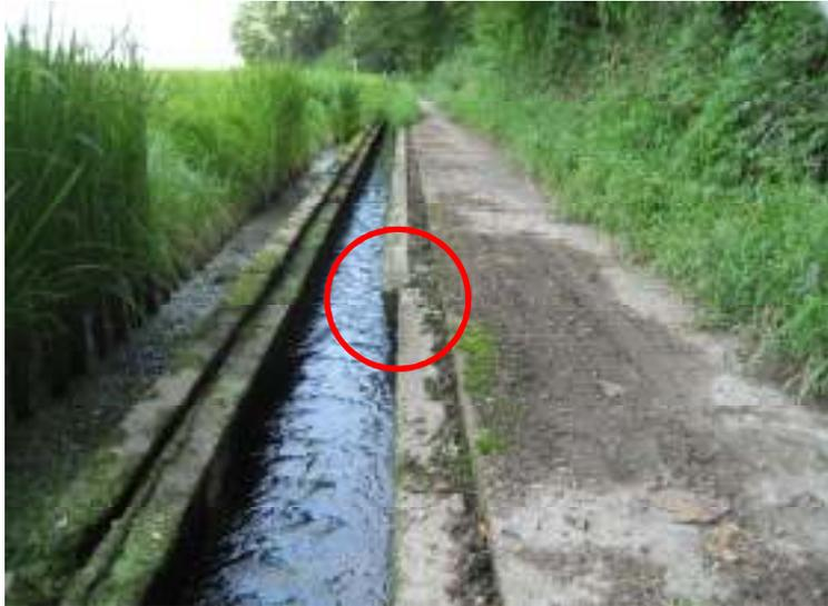
①水路が老朽化で破損し、耕作に支障を来している。
