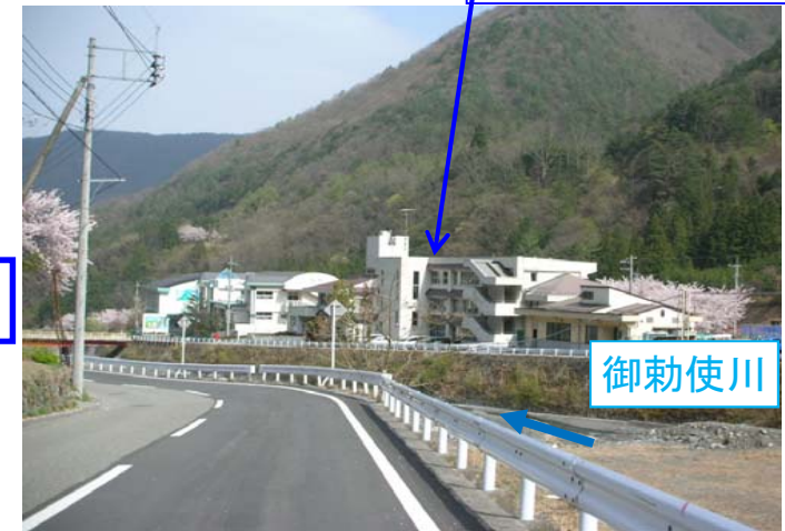
県道甲斐芦安線 (第二次緊急輸送道路)
