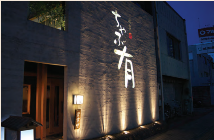
床から上方向に外壁を照らすことで、印象が変わるシンプルな外壁 ⑲
