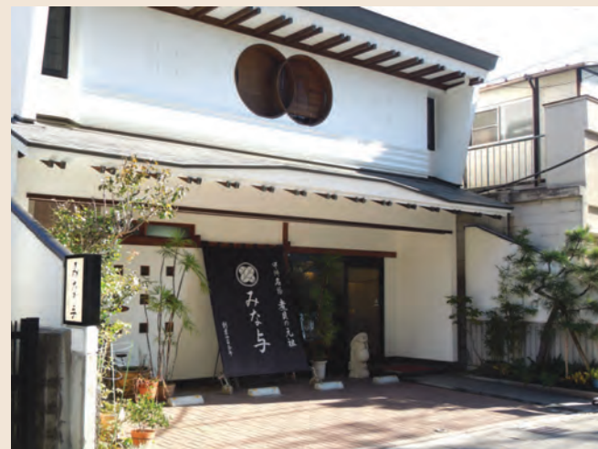
派手な色を用いず、素朴な色で構成した外壁と広告幕 ⑮
