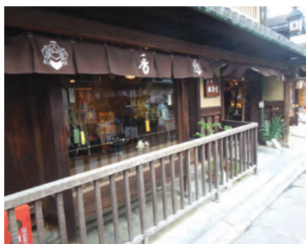
外壁と合わせて和の佇まいを演出するのれんと壁面広告物
