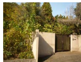
放置化した空家
