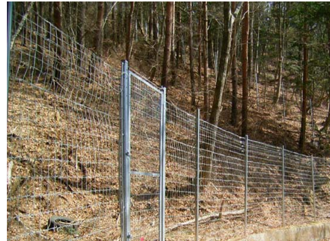
② 鳥獣害防止柵 サル、シカ、イノシシによる被害発生が減少している。
