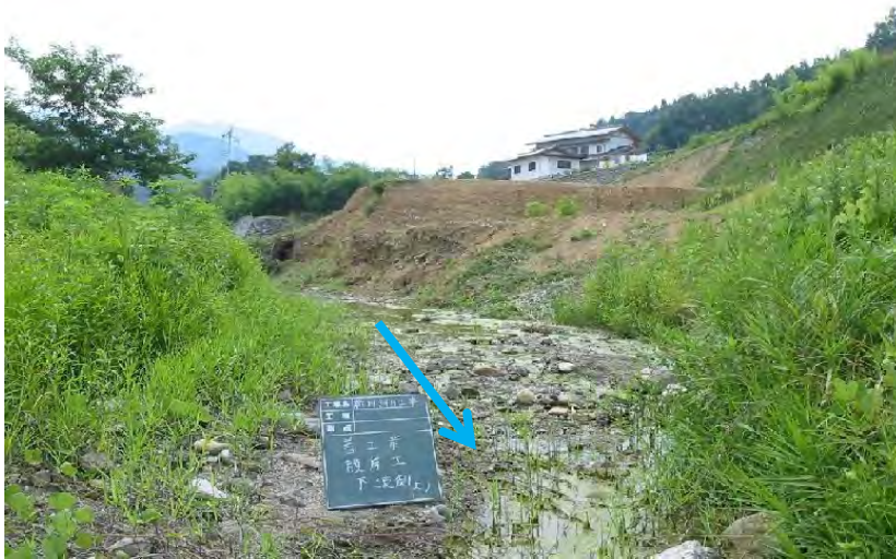
①新川橋下から左岸撮影
