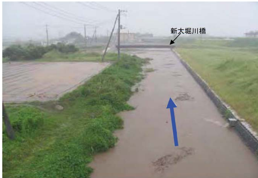
写真⑤ 国道358号橋（平和通り）より下流方向 21日15時40分頃
