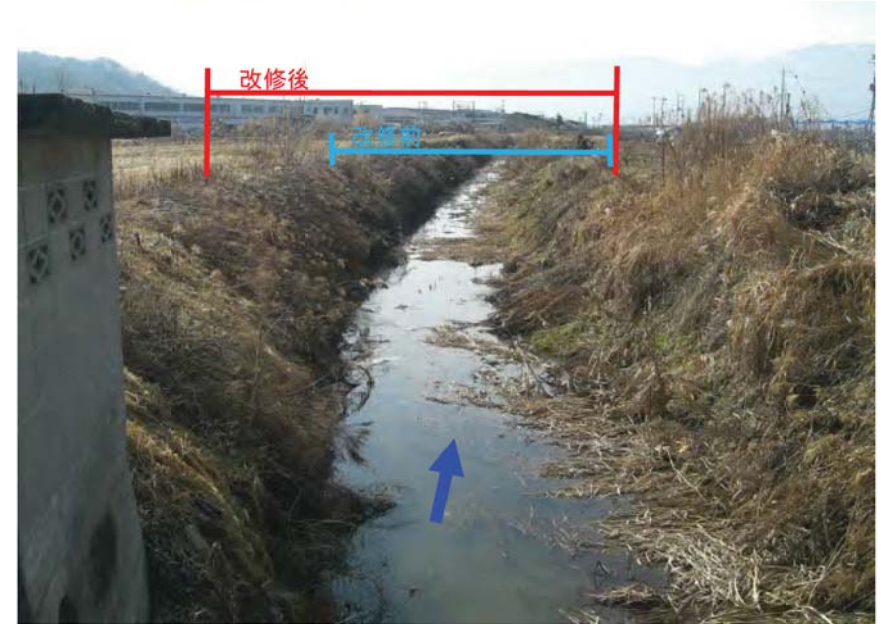
写真④ 改修区間上流端より下流の様子（改修前）
