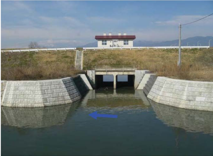
写真③ 新設放水路の様子（改修後）
