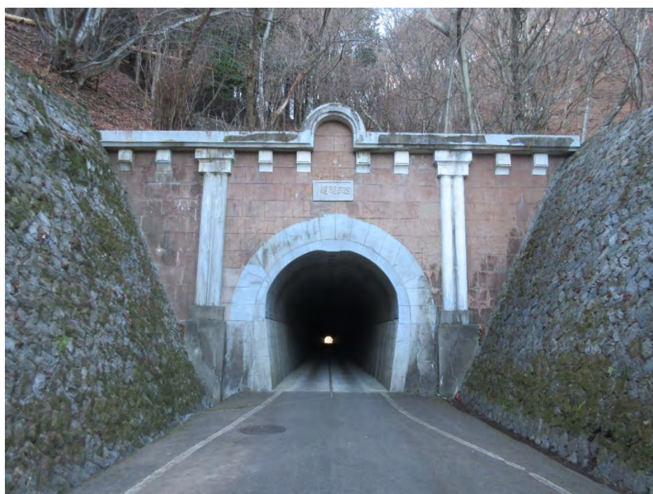
日影笹子線（県道 212 号） 笹子隧道
