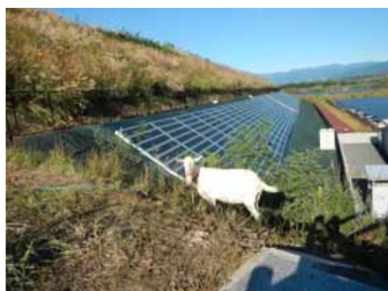
自然エネルギーを使った太陽光発電 環境に配慮した動物による除草 (甲府市 米倉山メガソーラー) (写真：2.26)
