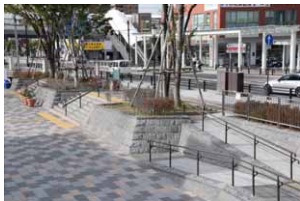
スロープ、点字ブロック、2段手すりを取り入れて広場の整備 (甲府駅北口)
