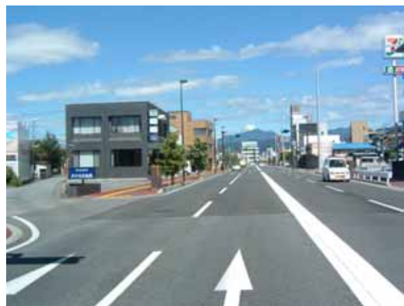
電線類地中化（後）（国道358号）
