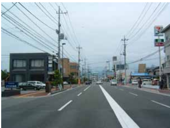
電線類地中化（前）（国道358号） (写真：2.17)
