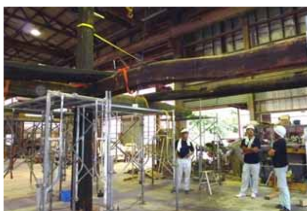
古民家再生 (古材の大黒柱・梁の仮組み状況) (写真: 2. 43)
