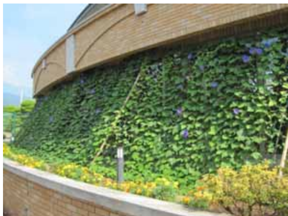
緑のカーテンによる緑化 (南アルプス市 櫛形図書館) (写真：2.23)
