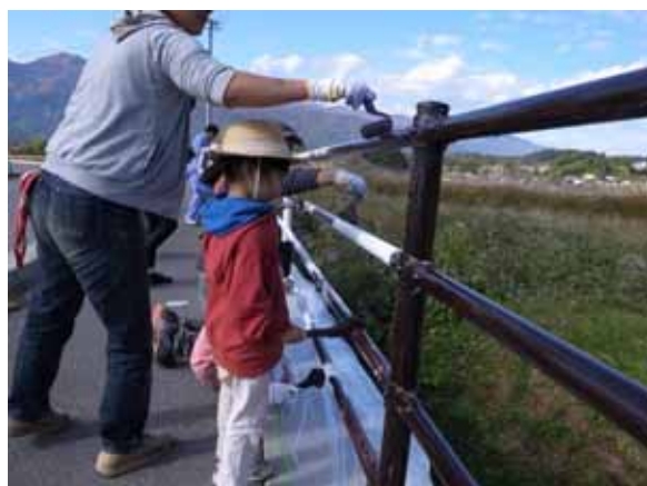
景観に配慮した色への塗り替え作業
