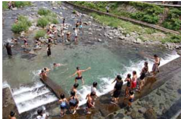
生態系に配慮した整備 (道志村 道志川の魚道) (写真：2.22)
