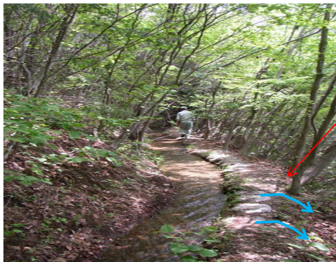
着工前 未改修の土水路で少量の雨量でも溢水し、 土のうを設置し被害の軽減を図っていた。
