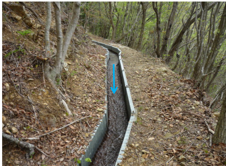
完成後 水路を改修し、通水能力を向上させたため、 下流農地への用水供給が安定した。
