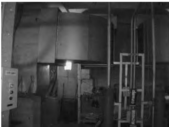
図23 煙突室 (煙突基部空間)
