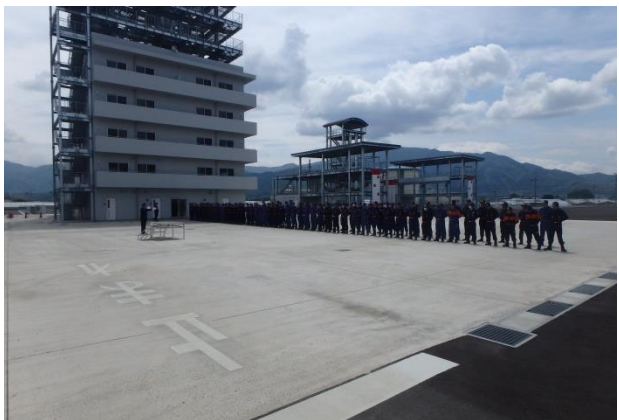
全天候型放水訓練施設
