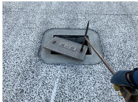
(2) 蓋を開けると、中に元金具（オス）と突起部があり、突起部に消火栓キーハンドルを差し込み、反時計回りにひねると水が出る。
