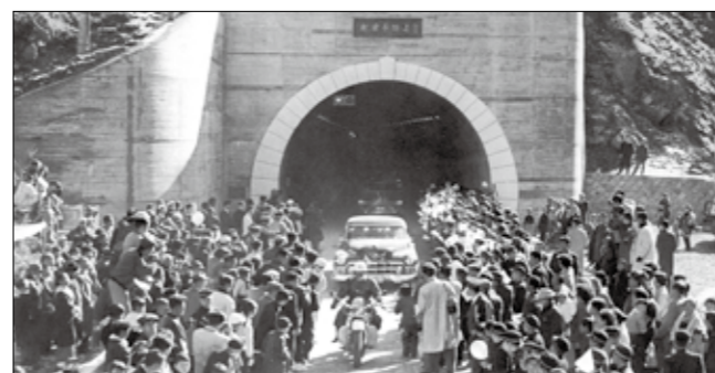
新笹子トンネル開通
