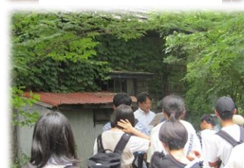
武蔵航空の変電所跡
