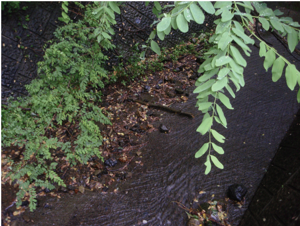
写真 1-4-2 A 沢三面張水路下流
