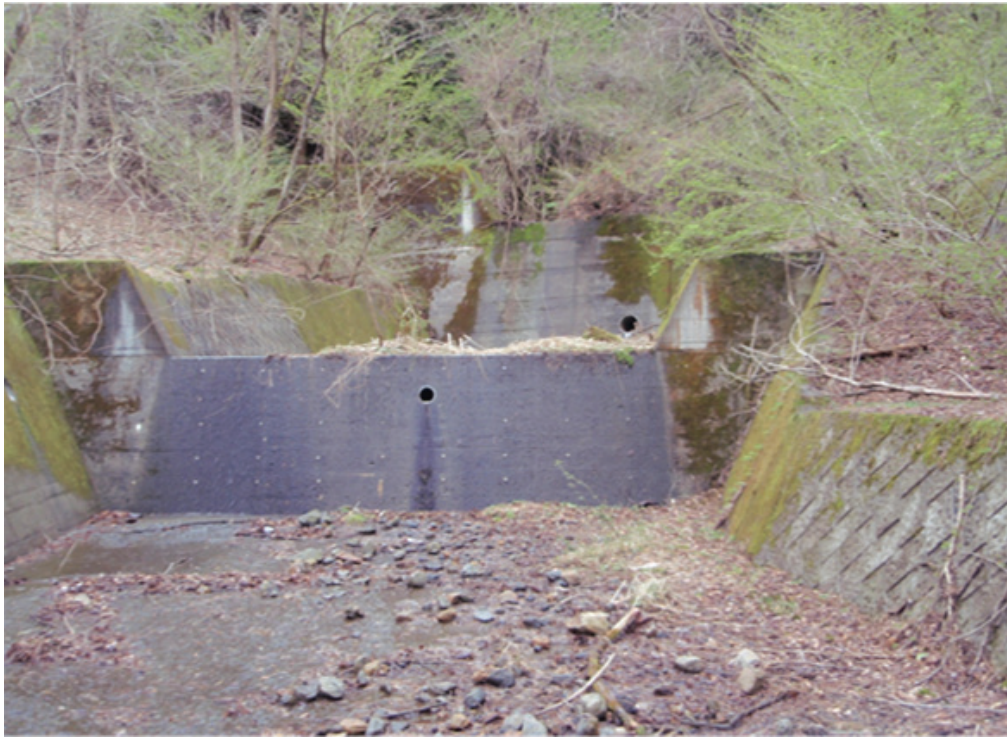
写真 1-4-1 A 沢三面張水路上流
