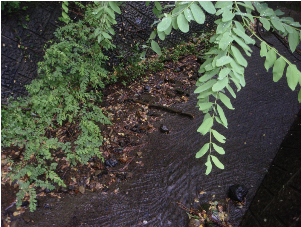
写真 1-4-2 A 沢三面張水路下流
